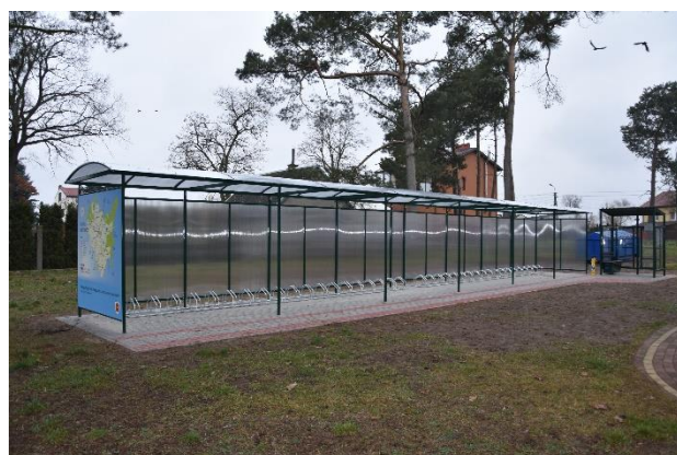
Wiaty rowerowa wyposażona w panel fotowoltaiczny ze stacją naprawy rowerów (Stacja BikeStop)
