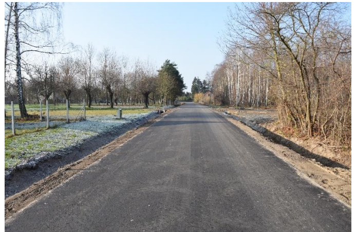
Przebudowa drogi gminnej nr 301144W w miejscowości Milewo
