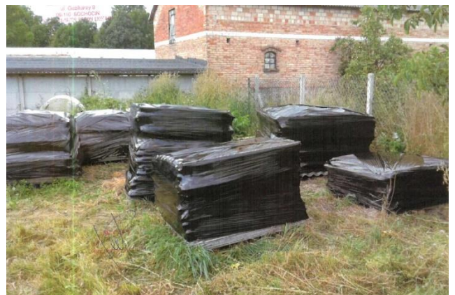
Demontaż, odbiór, transport i utylizacja wyrobów zawierających azbest z terenu Gminy Sochocin
